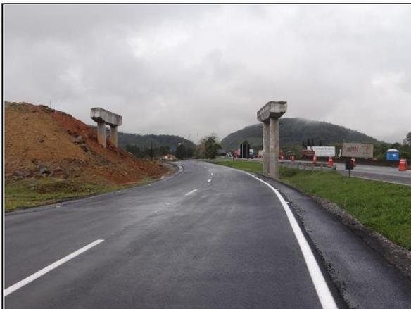
Foto 19 – Via marginal à BR-101 com pavimento concluído. A esquerda, o aterro da cabeceira leste.
