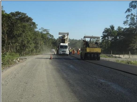
Foto 11 – Execução da capa asfáltica entre os kms 7+400 e 7+800, aproximadamente.
