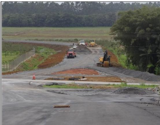
Foto 07 – Execução de camada final em aterro em rocha (km 0+900 aproximadamente)
