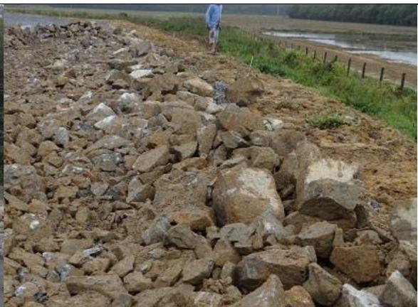
Foto 08 – Detalhe do material usado no aterro em rocha.
