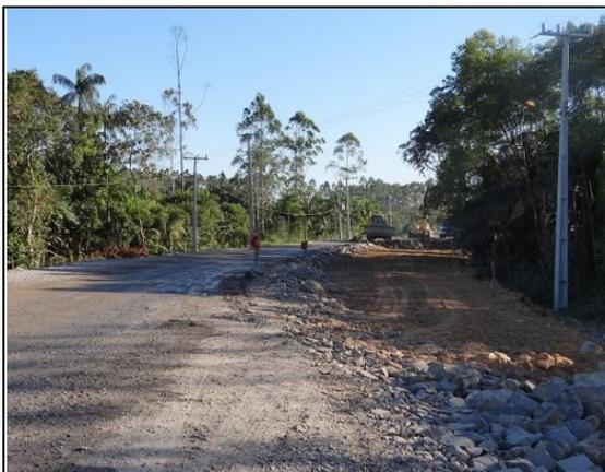
Foto 09 – Execução de camadas do pavimento entre os kms 7+400 e 7+800, aproximadamente.
