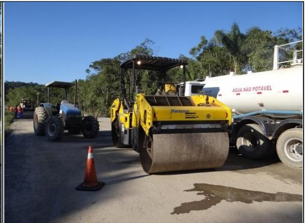
Foto 12 – Equipamentos utilizados na execução da capa asfáltica.
