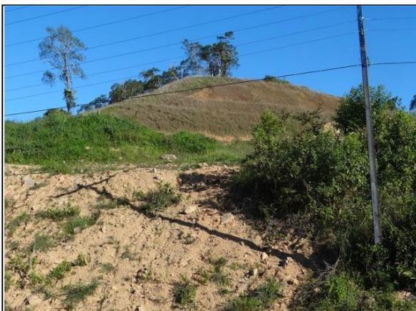
Foto 15 – Ao fundo, banqueteamento em solo, no segmento final do trecho, junto a SC 417.
