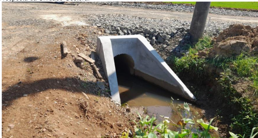
Figura 7 - Boca de bueiro revestida de argamassa Fonte: Documento resposta da Unidade Gestora.
