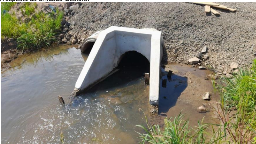
Figura 3 - Boca de bueiro revestida de argamassa
