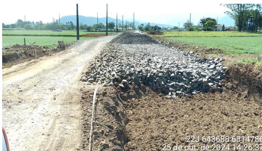
Figura 8 - Execução de reforço de subleito em rachão
