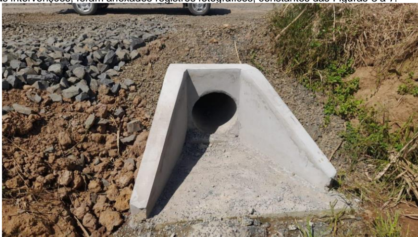
Figura 3 - Boca de bueiro revestida de argamassa
