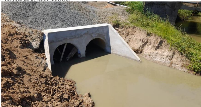
Figura 6 - Boca de bueiro revestida de argamassa Fonte: Documento resposta da Unidade Gestora.
