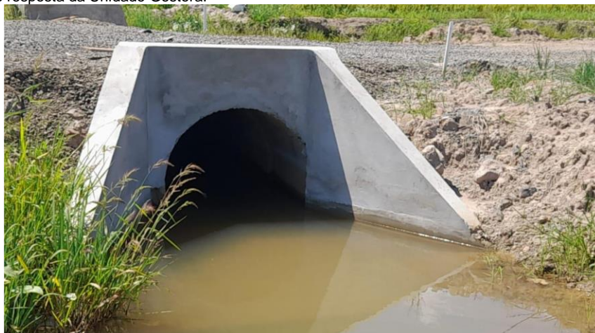
Figura 5 - Boca de bueiro revestida de argamassa Fonte: Documento resposta da Unidade Gestora.
