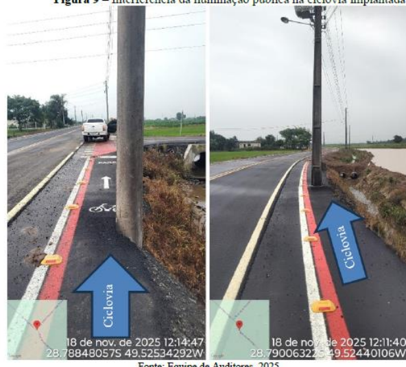
Figura 9 – Interferência da iluminação pública na ciclovia implantada
