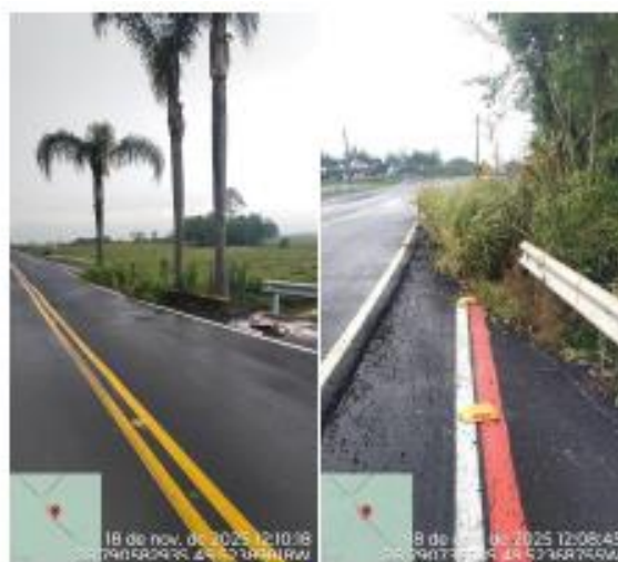
Figura 12 – Acidente decorrente de defesa com extremidade sem tratamento adequado
