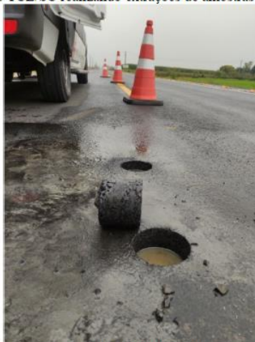
Figura 2 - Equipe do TCE/SC realizando extrações de amostras do pavimento na obra
