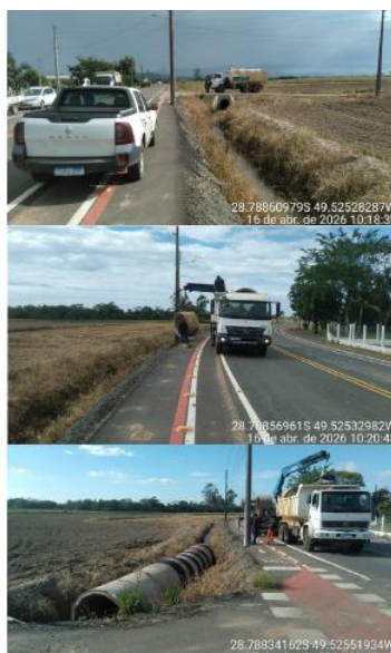
A Prefeitura, por meio da sua Secretaria de Infraestrutura, pretende finalizar as obras de drenagem e aterro do canal em quinze dias, a depender das condições
