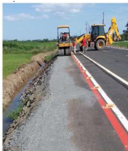
Figure 3 - Correção das trincas na borda do pavimento
