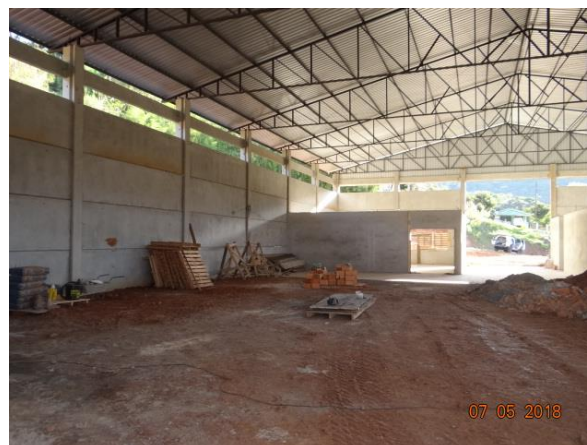
Foto 15 – Vista da garagem de veículos.
