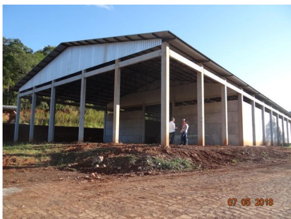
Foto 3 – Garagem de máquinas, vista fundo
