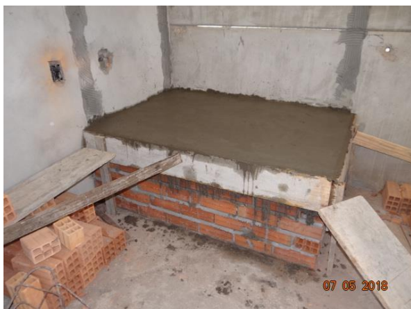
Foto 12 – Laje suspensa, executada na cozinha.
