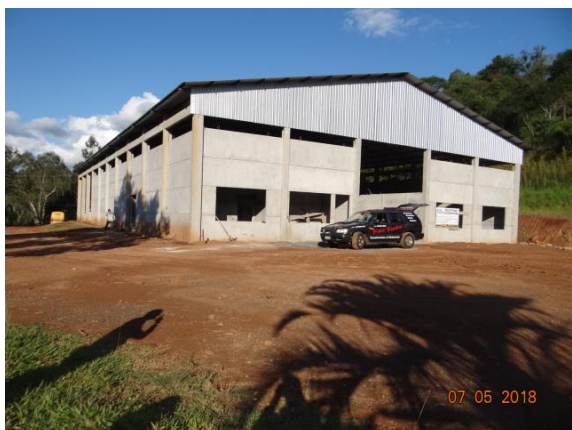
Foto 1 – Garagem de maquinas, vista frontal
