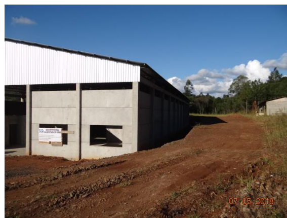
Foto 4 – Garagem de máquinas, vista lateral rente ao barranco
