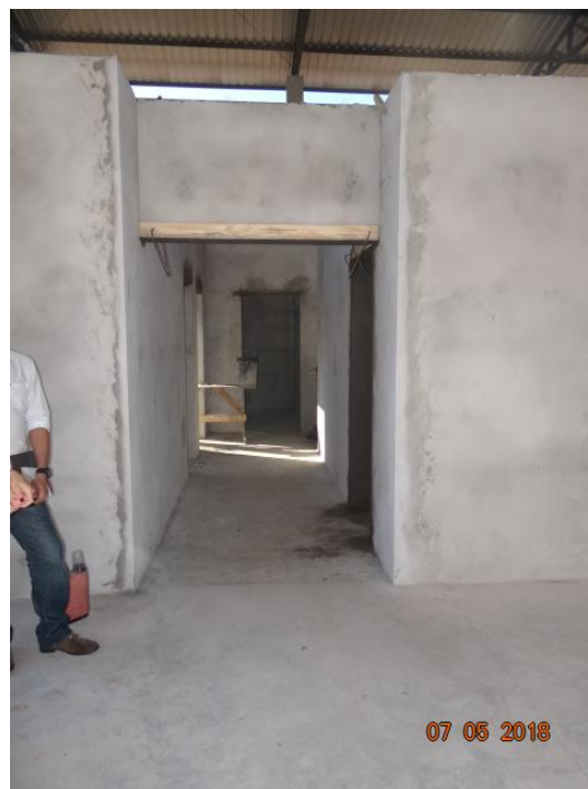
Foto 9 – Corredor de acesso as salas administrativas.
