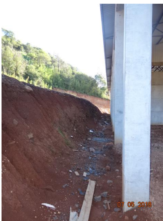
Foto 16 – Vista do talude rente à edificação.
