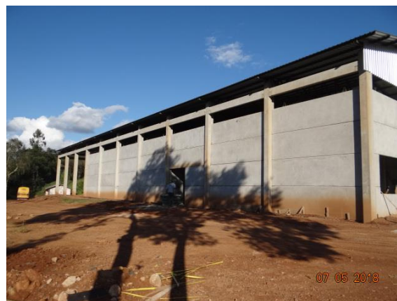
Foto 2 – Garagem de maquinas, vista lateral
