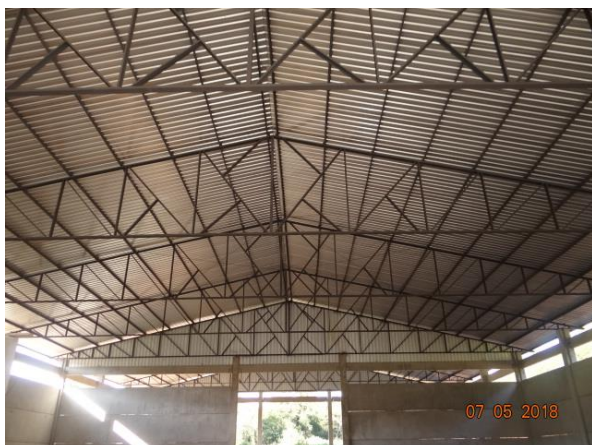
Foto 14 – Vista do telhado.
