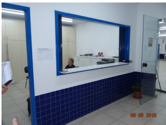
FOTO 25 – Secretaria reformada. Nesta parte administrativa da escola foi retirado os tacos de madeira, e forro que existia. Foram executados o piso cerâmico, e o forro em PVC. As paredes receberam pintura acrílica.
