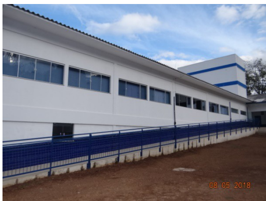
FOTO 7 – Vista dos fundos da escola. Parte ampliada.
