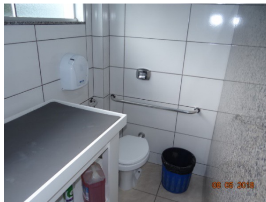
FOTO 18 – Banheiro feminino novo, para deficientes.
