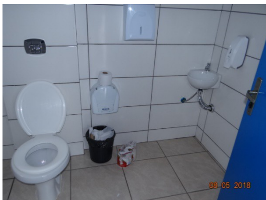
FOTO 31 – Banheiro dos funcionários novo, dentro da parte antiga da escola, com acesso pela área de recreação. Piso cerâmico e azulejo nas paredes. Louças e acessórios novos.
