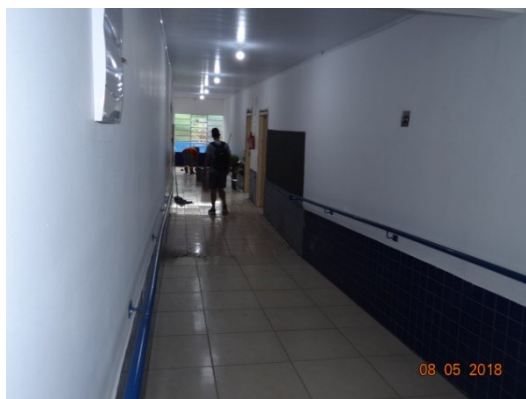
FOTO 32 – Rampa nova executada em direção às salas de aula destinadas à creche. As paredes da circulação foram pintadas e receberam corrimão e pastilhas até 80cm de altura. As luminárias também são novas.
