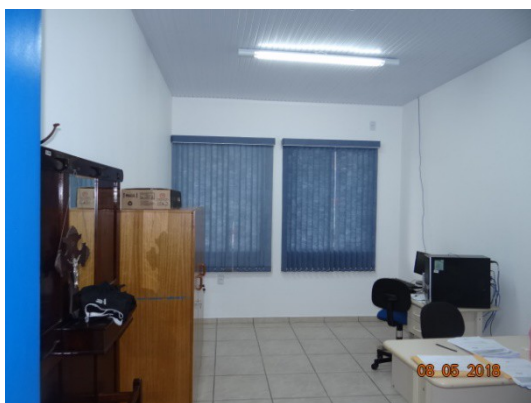
FOTO 27 – Auxiliar de Direção, reformada. Piso cerâmico, forro em PVC e pintura acrílica.
