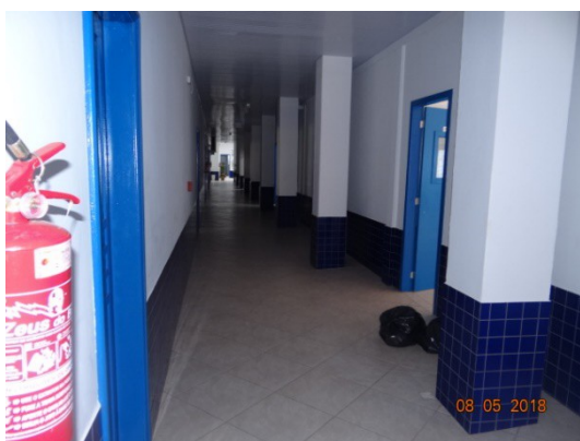
FOTO 9 – Corredor da parte ampliada.
