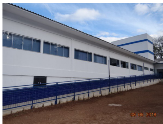
FOTO 2 – Vista dos fundos.
