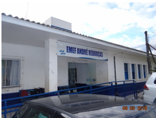
FOTO 3 – Entrada da escola. Área objeto da reforma. Pintura externa ainda a ser executada.
