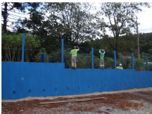
FOTO 37 – Muro de contenção concluído. Colocação de tela. Ambos os serviços objeto do termo aditivo.
