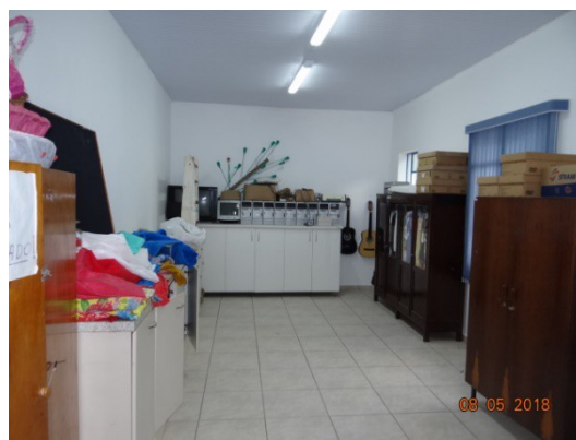
FOTO 28 – Depósito reformado. Piso cerâmico, forro em PVC e pintura acrílica.
