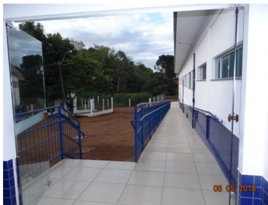
FOTO 6 – Vista dos fundos da escola. Obras novas de ampliação.
