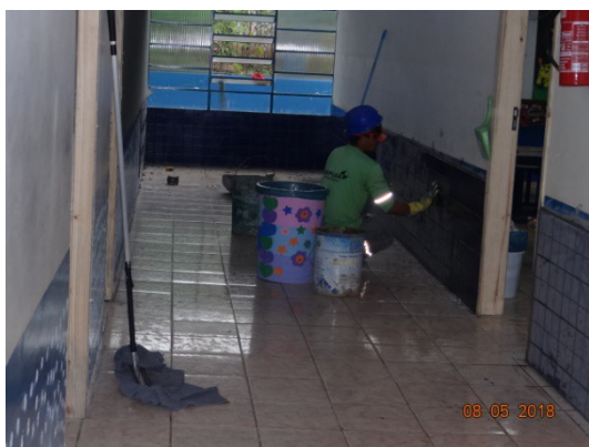
FOTO 33 – Aplicação de rejunte nas pastilhas das paredes do corredor das salas de aula destinadas à creche.
