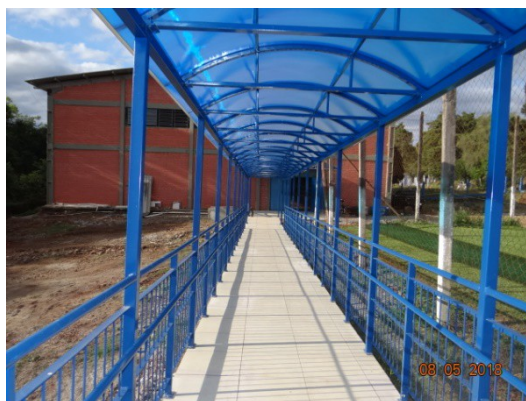
FOTO 40 – Acesso novo para o ginásio de esportes existente.
