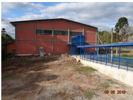
FOTO 41 – Acesso para o ginásio existente.
