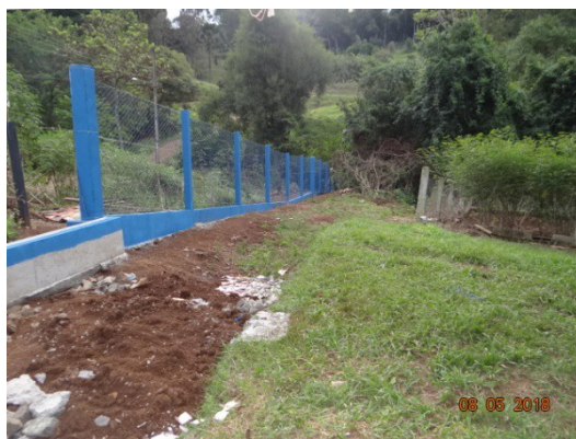
FOTO 38 – Estrutura de concreto e fechamento do terreno com telas, objeto do aditivo de valor.
