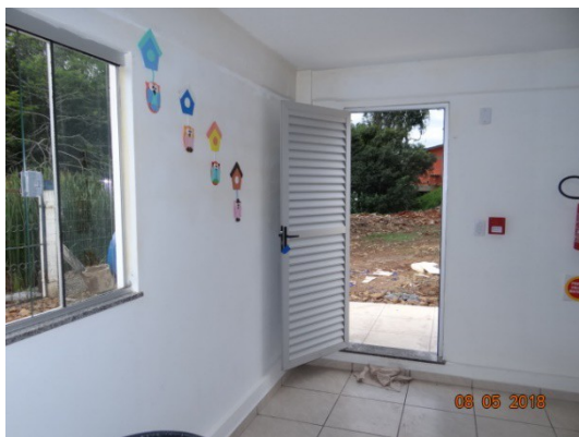
FOTO 21 – Entrada da sala no pavimento inferior que já existia. Já está sendo utilizada como depósito de materiais esportivos e sala de música.
