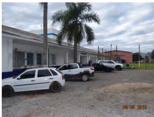
FOTO 4 – Vista da fachada frontal, parte objeto da reforma.
