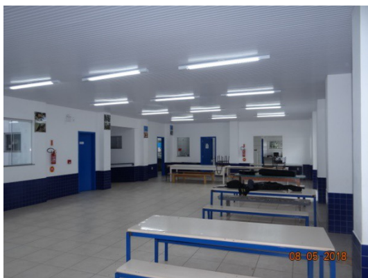
FOTO 19 – Recreação reformada. Foi demolida uma cozinha que existia no local. Piso cerâmico novo, pastilhas na parede e pintura. Forro antigo foi substituído por forro de PVC.
