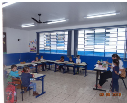
FOTO 34 – As quatro salas de aula destinadas à creche tiveram as paredes pintadas e foram trocadas as portas, parte elétrica e luminárias. O forro e o piso foram mantidos, com exceção de uma sala, que teve uma parte do piso substituída também.
