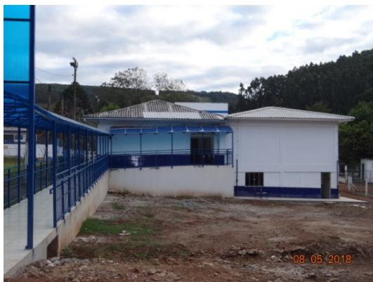
FOTO 5 – Vista lateral da escola. O bloco da esquerda e pavimento inferior do bloco da direita já existiam. À direita, em destaque, a parte nova da obra, a ampliação.
