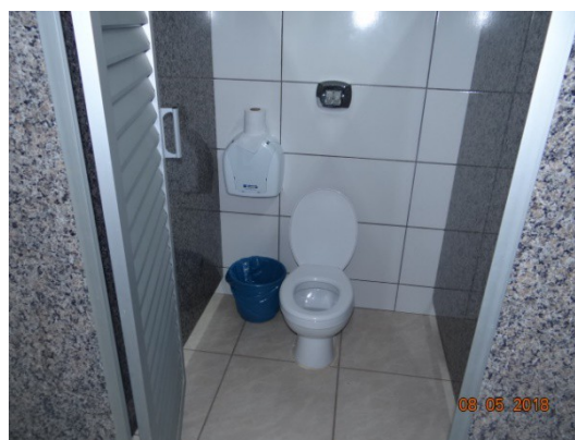
FOTO 16 – Banheiro feminino novo.
