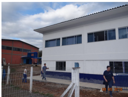
FOTO 8 – Vista dos fundos da escola. Parte ampliada.
