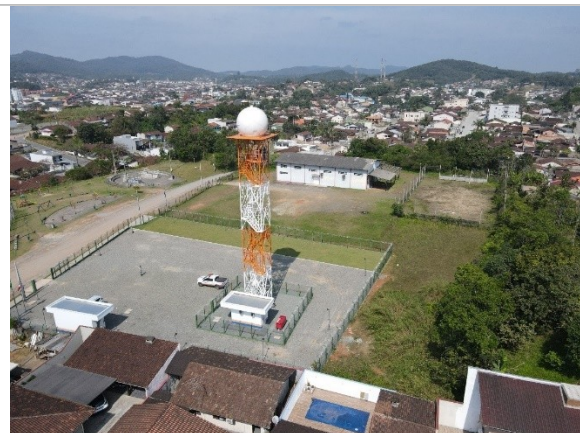
Fonte: imagem feita por drone no dia 22/08/2023 - DJI0442
