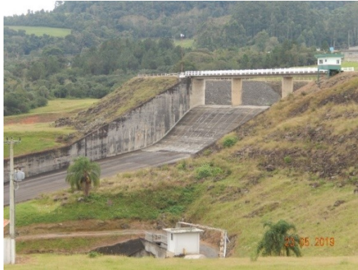
Foto DSCN1183: Taludes de jusante e vertedouro central sobre-elevado.
