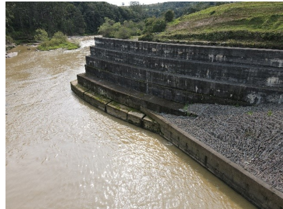
Foto DJI0728: Muro e colchões de gabião executados.
