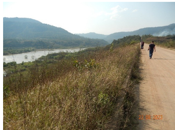
Foto DSCN3707: Coroamento.
