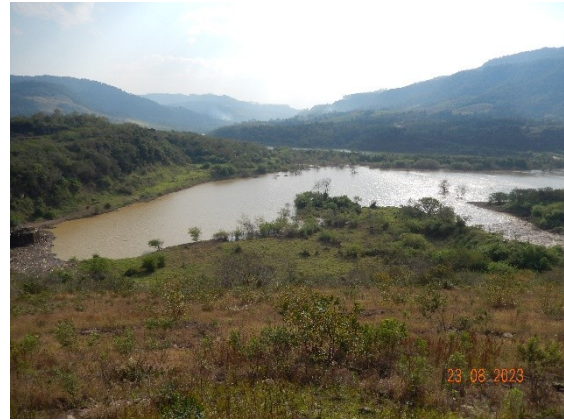
Foto DSCN3717: Talude de montante.
