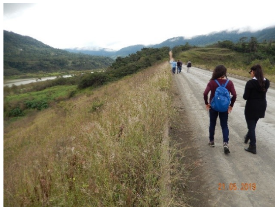
Foto DSCN0894: Coroamento.
