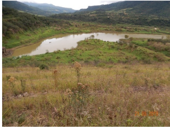
Foto DSCN0892: Talude de montante.
