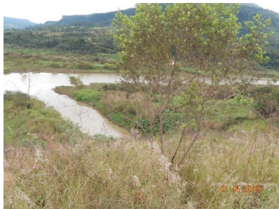
Foto DSCN0899: Talude de montante. Tomada d'água dos descarregadores de fundo permanentes (sem comporta).
