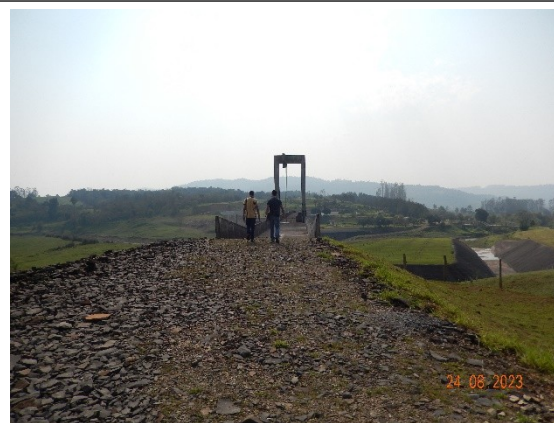
Foto DSCN3907: Canal extravasor. Sem alterações.
