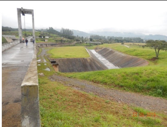
Foto DSCN1020: Canal extravasor finalizado.
