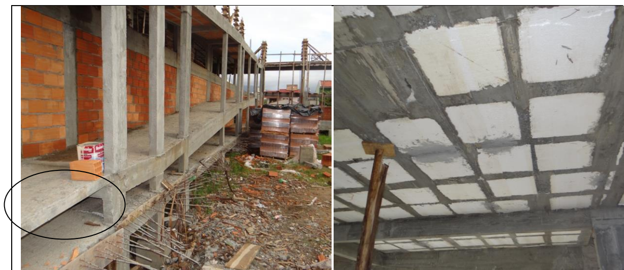
Foto 12 – Laje da rampa sem viga de borda
