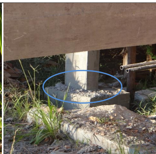
Foto 19 - Pilar P187 excêntrico ao bloco
