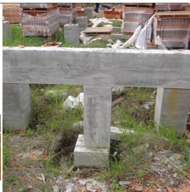
Foto 17 – Pilar P 186 excêntrico ao bloco de fundação.
