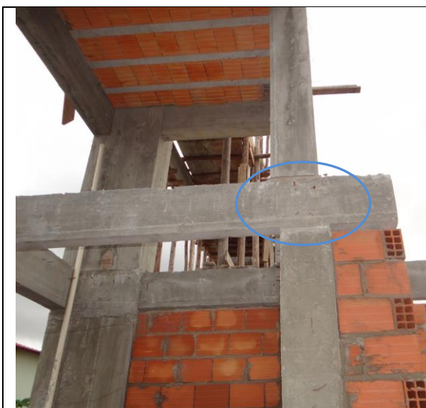
Foto 16 - Pilar P229 do 1º pavimento excêntrico em relação ao térreo
