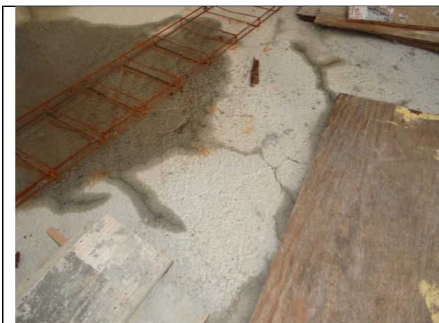
Foto 14 – Fissuras na laje do 2º pavimento
