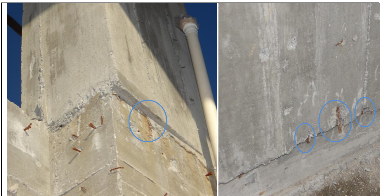
Foto 10 – P240 com armadura exposta
