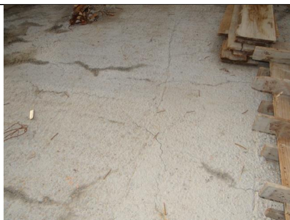
Foto 15 – Fissuras na laje do 2º pavimento
