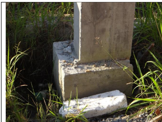
Foto 18 - Pilar P177 excêntrico ao bloco
